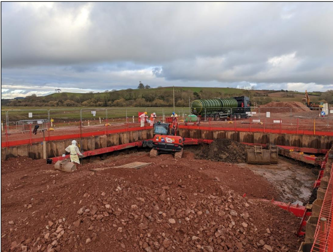
Photo 3. Excavation de la zone contaminée (Source : Kier)
