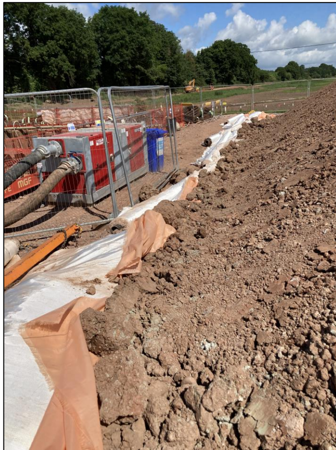
Photo 1. Géotextile d'avertissement orange sous le nouveau talus (Source : Environment Agency)
