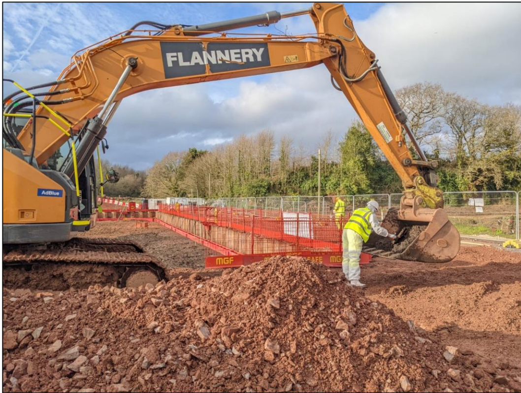
Photo 2. Matières excavées contrôlées pour identifier toute présence d'amiante (Source : Kier)
