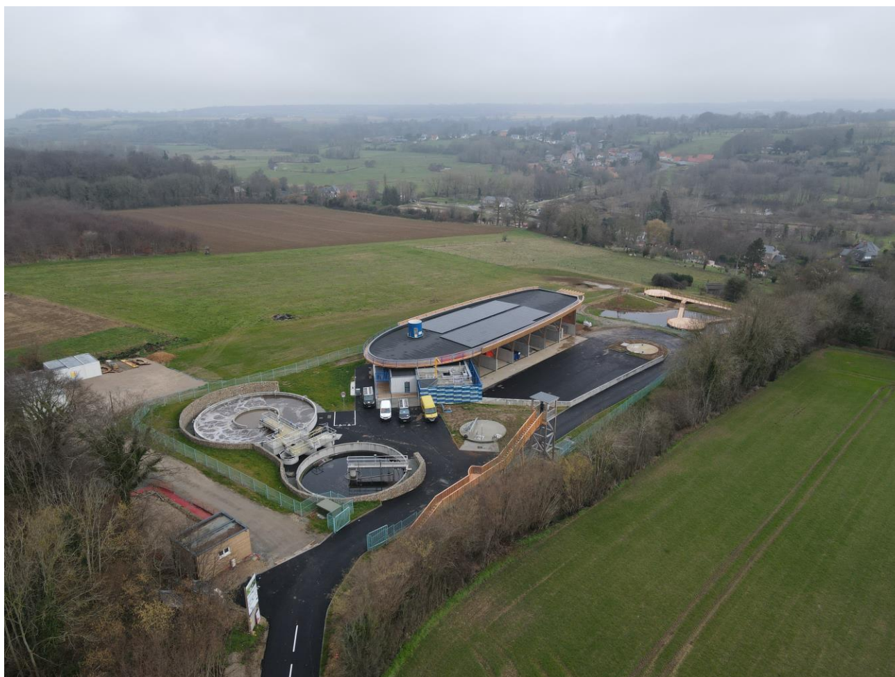
Photo 7.3 La nouvelle station d'épuration "Soléa" à Longueil. (Source : Thomas DROUET/Cdl, 2023)
