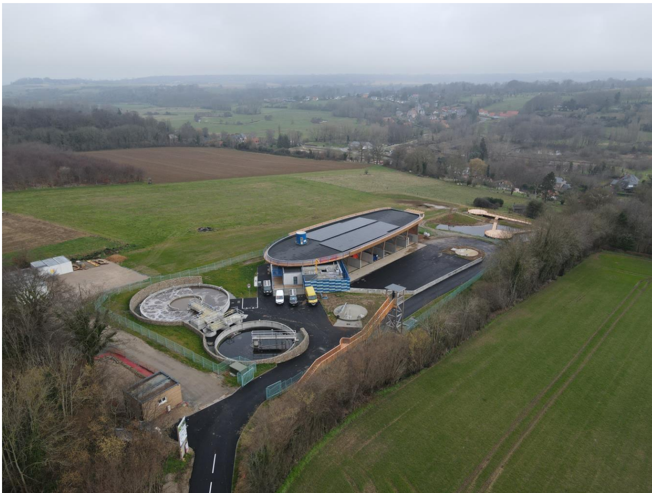
Photo 2.9 La station d'épuration en construction (Source : Thomas Drouet/Cdl, 2023)
