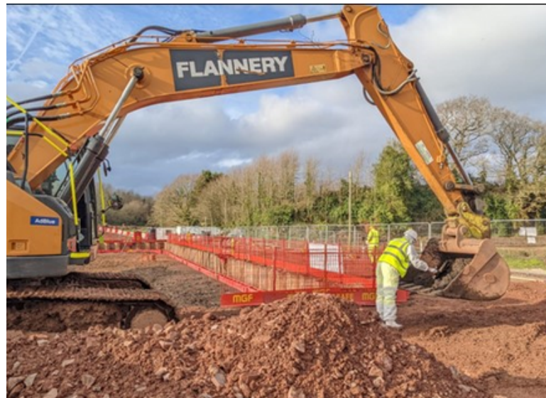
Les travaux sur le site de la décharge, Environment Agency
