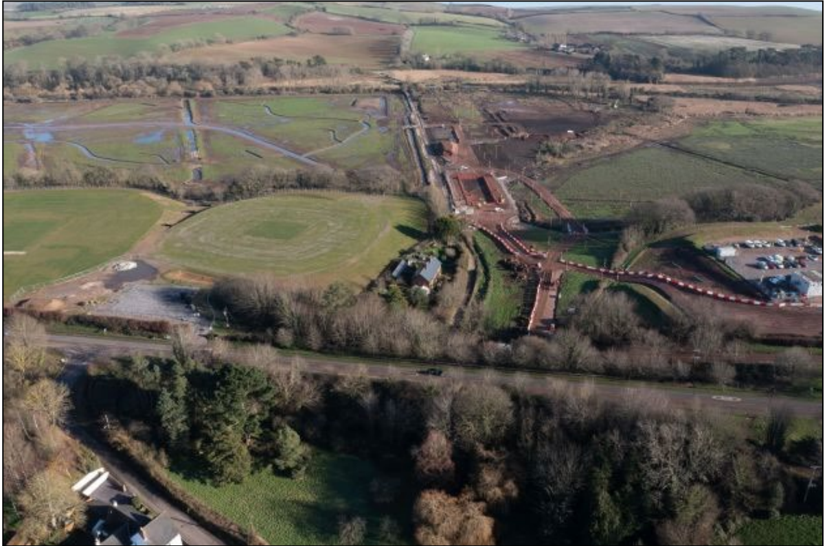
Photo F Travaux techniques visant à surélever South Farm Road et à construire un nouveau pont
